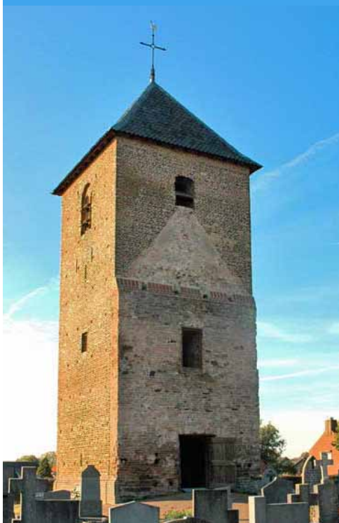
Toren afgebroken kerk op begraafplaats Afferden
